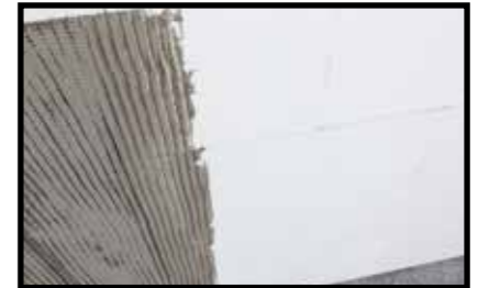
Auftragung der ersten Schicht PLANITOP HDM MAXI
