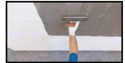
Auftragen des Klebstoffes mit einer Zahnpachtel in senkrechter Richtung
