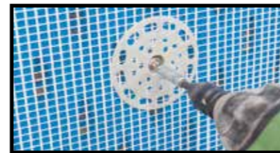
Verdübelung: Mindestens 5 Dübel pro m 2
