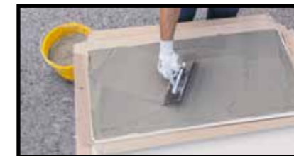
Doppelte Auftragung (Rückseite ZERO.3)
