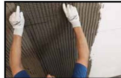
Anbringen des Netzes MAPEGRID G 120
