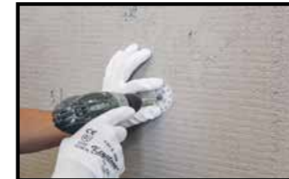
Verdübelung MIT MAPETHERM TILE FIX15
