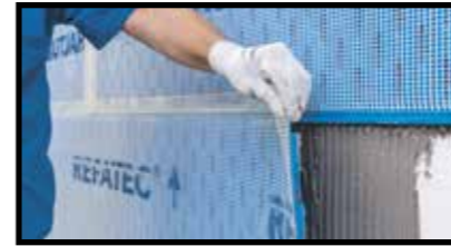
Einpassen der Isoliermatten CeraVent von oben nach unten, verschoben
