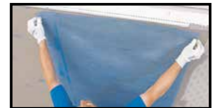
Einpassen des Armierungsnetzes CeraVent
