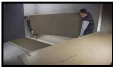
Abb.31 - Beim Tragen der Platten, die Platten zuerst senkrecht stellen und sie dabei am oberen Rand halten; dann die Platte beim Gehen immer mit Hilfe einer Zweitperson gerade haltend befördern.
