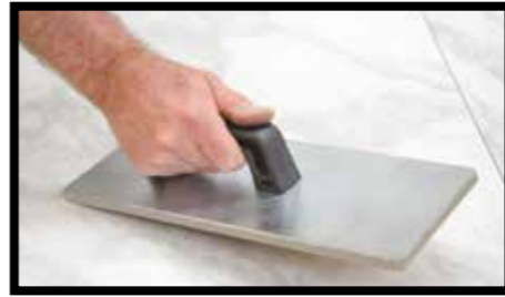
Abb.30 - Nach dem Verlegen der Platte darauf achten, dass der Kleber an allen Stellen gut haftet und keine Leerstellen und Luftblasen entstehen. Zu diesem Zweck müssen gummierte Putzbretchen verwendet werden (zum Beispiel Raimondi "142G").
