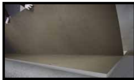
Abb.32 - Beim Verlegen eine der langen Seiten ansetzen und dann zur Tragschicht hin absenken.
