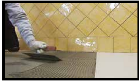
Abb.28 - Diese Technik eignet sich ausschließlich für Kleber, die im Datenblatt des Herstellers die Aufschrift „Verlegung mit einschichtigem Aufstrich“ enthalten. Den Kleber über die gesamte Oberfläche der Tragschicht verstreichen. Die Angaben des Kleberherstellers bezüglich der Spachtel- und Auftragart beachten.
